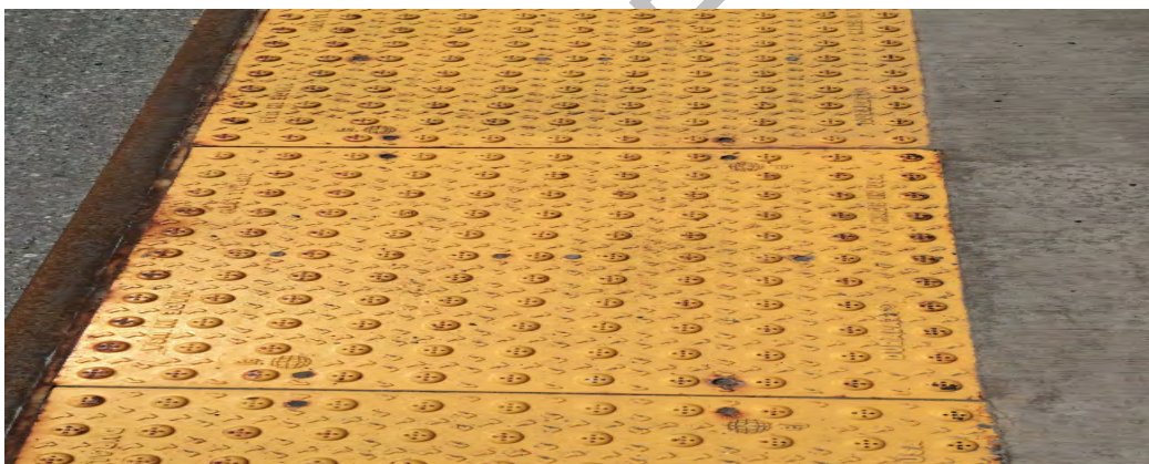
Photographie 2 – Podotactile en fonte
